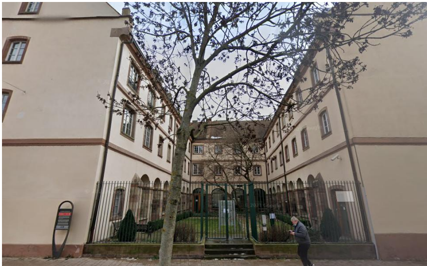
ESF Entrance at the green gate, 1 rue des Récollets
